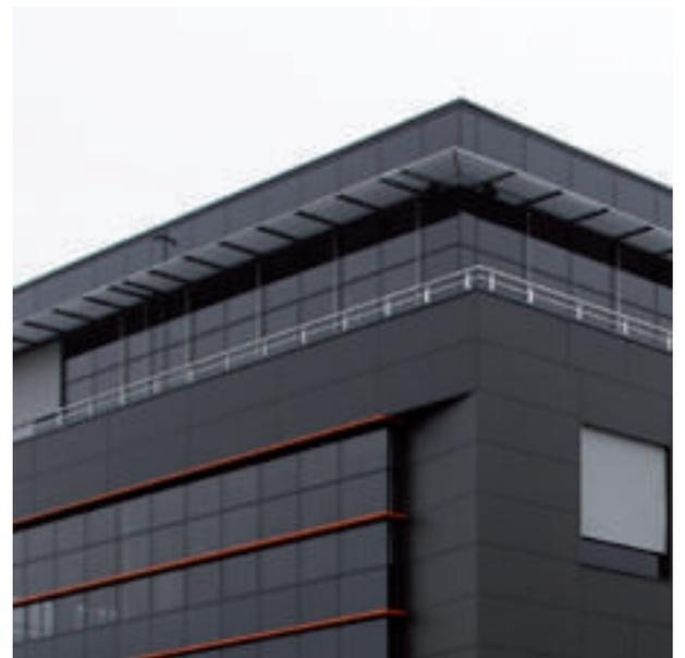
Die maximalen Abmaße des Systems **Sunbreaker 210** betragen 4000 mm (Breite) x 6020 mm (Höhe). Das System ist modular kombinierbar.
